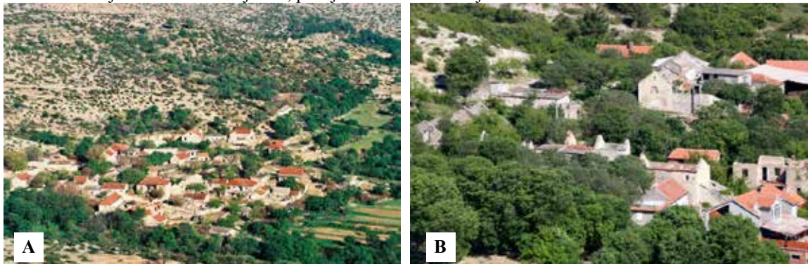
A: Lokacija i tip gradnje prije Domovinskog rata. B: Stanje nakon Domovinskog rata.
